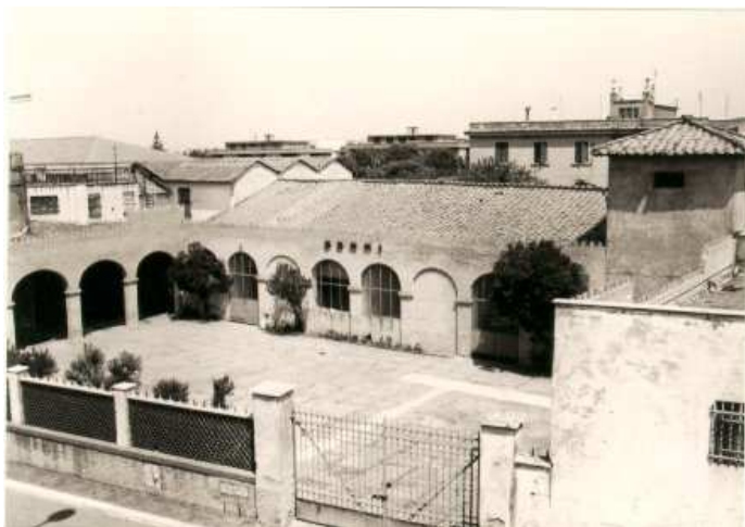
Lo stabilimento di Laboratori BORRI, sede del Centro di Formazione
